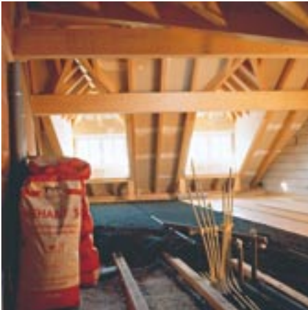
rénovation d'un plancher structure bois
